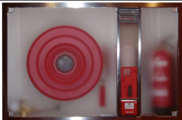
Detall d'un extintor, realitzat per AIA Salazar-Navarro.
