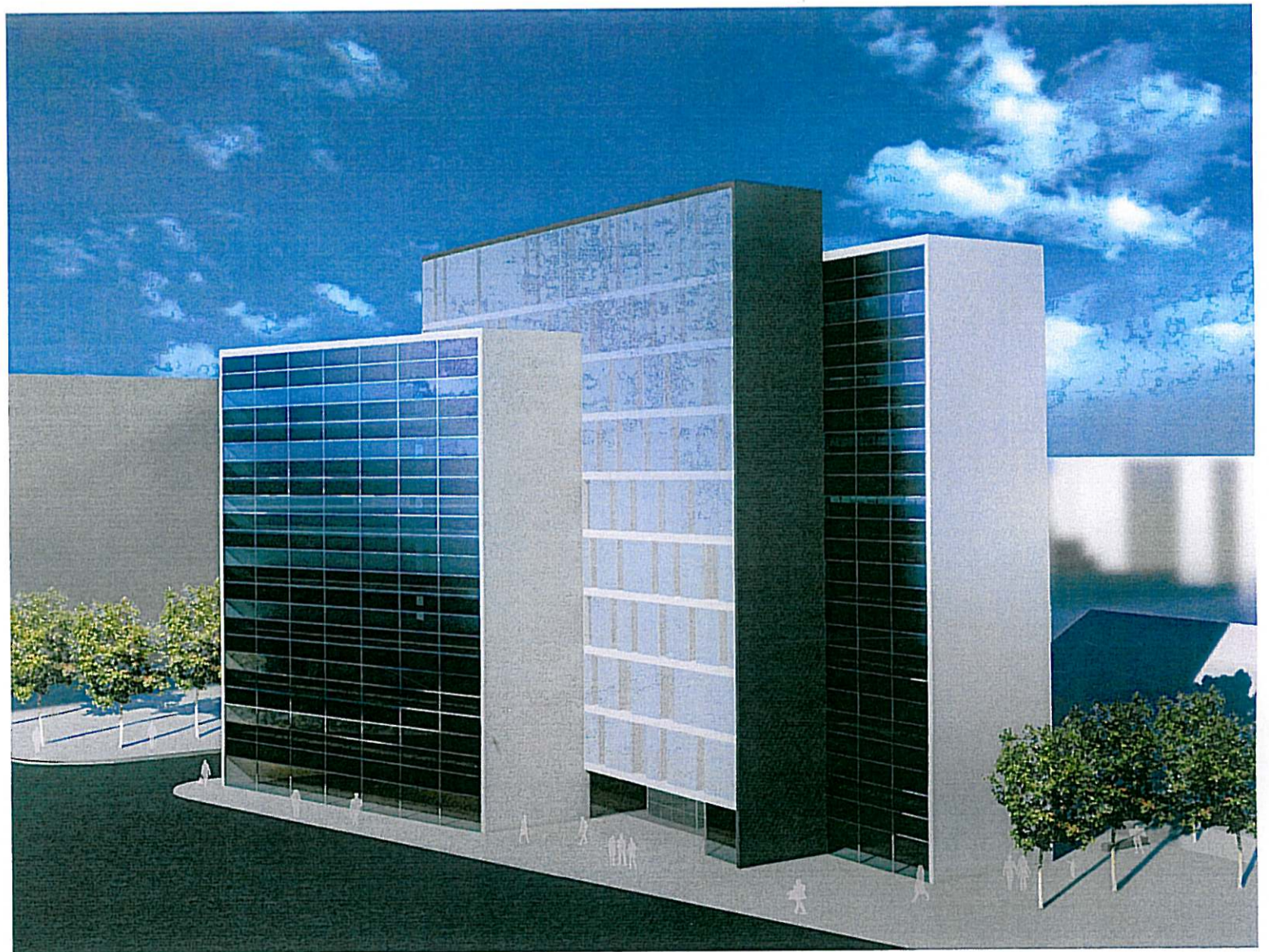
VISTA FAÇANA CARRER
