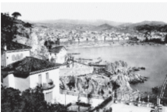
Xalets de la Urbanització de Sant Elm. Sant Feliu de Guíxols. Fons d'imatges de l'Arxiu Històric de la Demarcació de Girona del Col·legi d'Arquitectes de Catalunya (AHCOAC). Reg. 19024.
