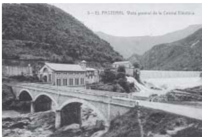
Central elèctrica El Pasteral. Cellera de Ter. Fons de postals de l'Arxiu Històric de la Demarcació de Girona del CoAC (AHCAC). Reg. 18616.
