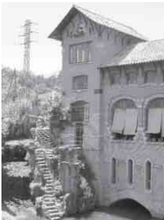
Central elèctrica a Bescanó, 2004. Autora de la fotografia: Sara Manté, arquitecta. Fons d'imatges de l'Arxiu Històric de la Demarcació de Girona del COAC (AHCOC). Reg. 31173.
