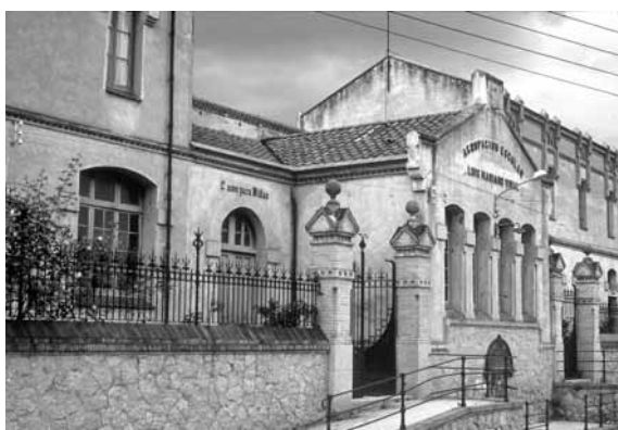
Les escoles d'Agullana (actualment CEIP Lluís Maria Vidal). Obra de l'arquitecte Josep Azemar. Fons d'imatges de l'Arxiu Històric de la Demarcació de Girona del Col·legi d'Arquitectes de Catalunya (AHCOAC). Reg. 7183.
