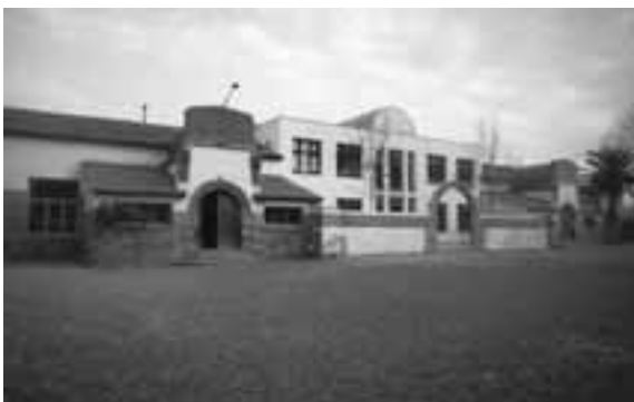
Escoles Municipals de Sant Gregori (actualment CEIP Agustí Gifre). Obra de Rafael Masó Valentí, 1917-1919. Ampliació posterior de Joan Tarrús i Jordi Bosch, 1976-1991. Fons d'imatges de l'Arxiu Històric de la Demarcació de Girona del Col·legi d'Arquitectes de Catalunya (AHCOAC). Reg. 11335.
