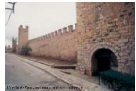
Muralla de Sant Jordi quasi totalment alliberada
