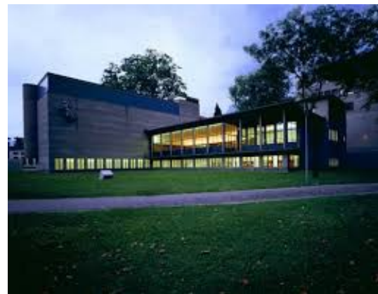
BIBLIOTECA CANTONALE-1942- ARCH. RINO TAMI
