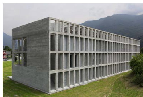
Nuova sede amministrativa AET, Monte Carasso (2015). Architetti Meyer, Piattini, Fallavollita
