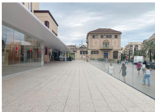
REORDENACIÓ ESPAI PÚBLIC I ACCÉS PRINCIPAL DEL MERCAT CENTRAL » REUS
