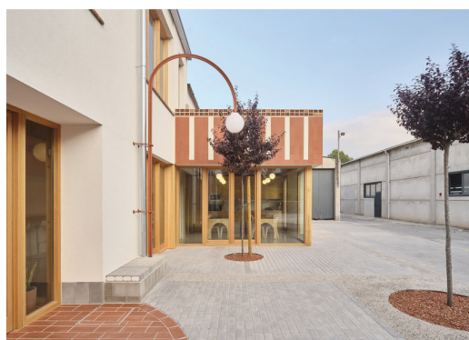
HABITAR LA INDUSTRIA. REHABILITACIÓ I AMPLIACIÓ OFICINES TUVATÈXIL » PONT D'ARMENTERA NUA architectures. Arnau Tiñena Ramos, Ferran Tiñena Guamet i Maria Rius Ruiz
