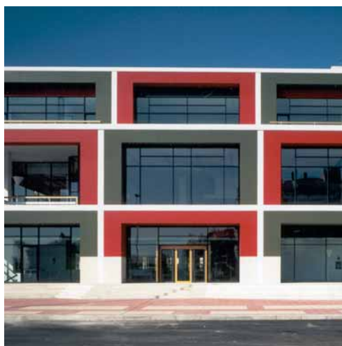
08.01 Biblioteca Regional de Murcia (Murcia). Arquitecto: José M. Torres Nadal.
